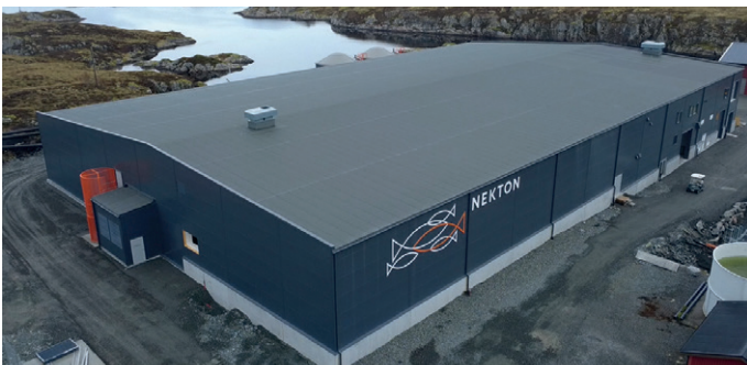
Det nye smoltanlegget til Nekton Settefisk på Smøla.
