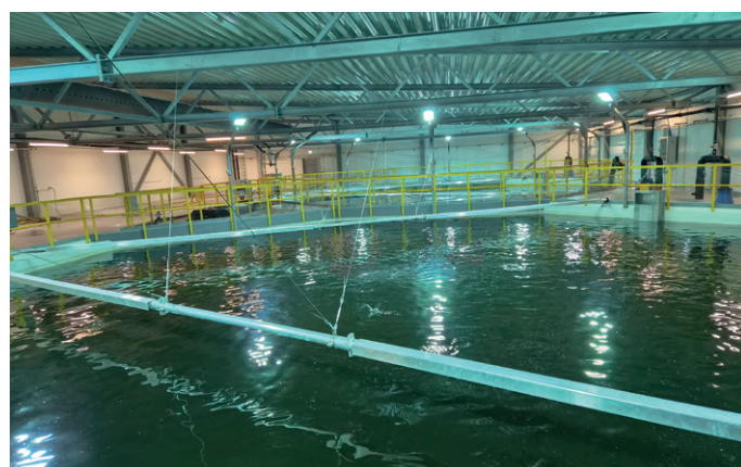
Den store påveksthallen med fire oktagonformede kar.
